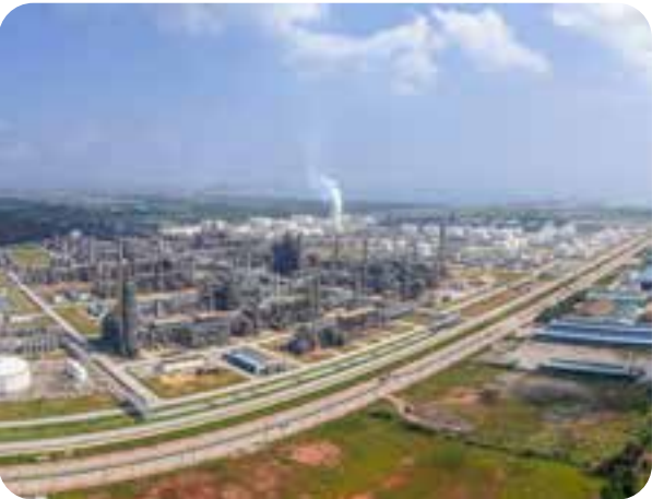
Nhà máy Lọc hóa dầu Nghi Sơn
