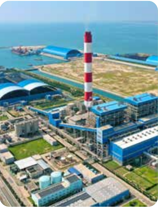
Nhà máy nhiệt điện Quảng Trạch I
